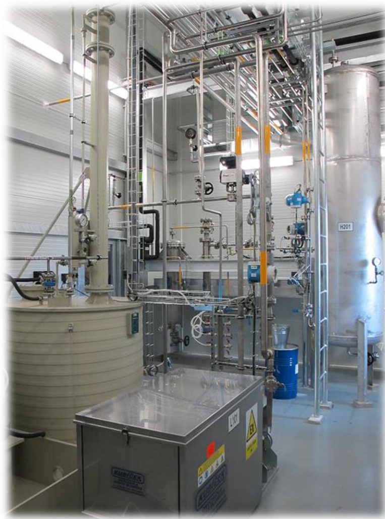
Spodní sekce s alkalickou pračkou
